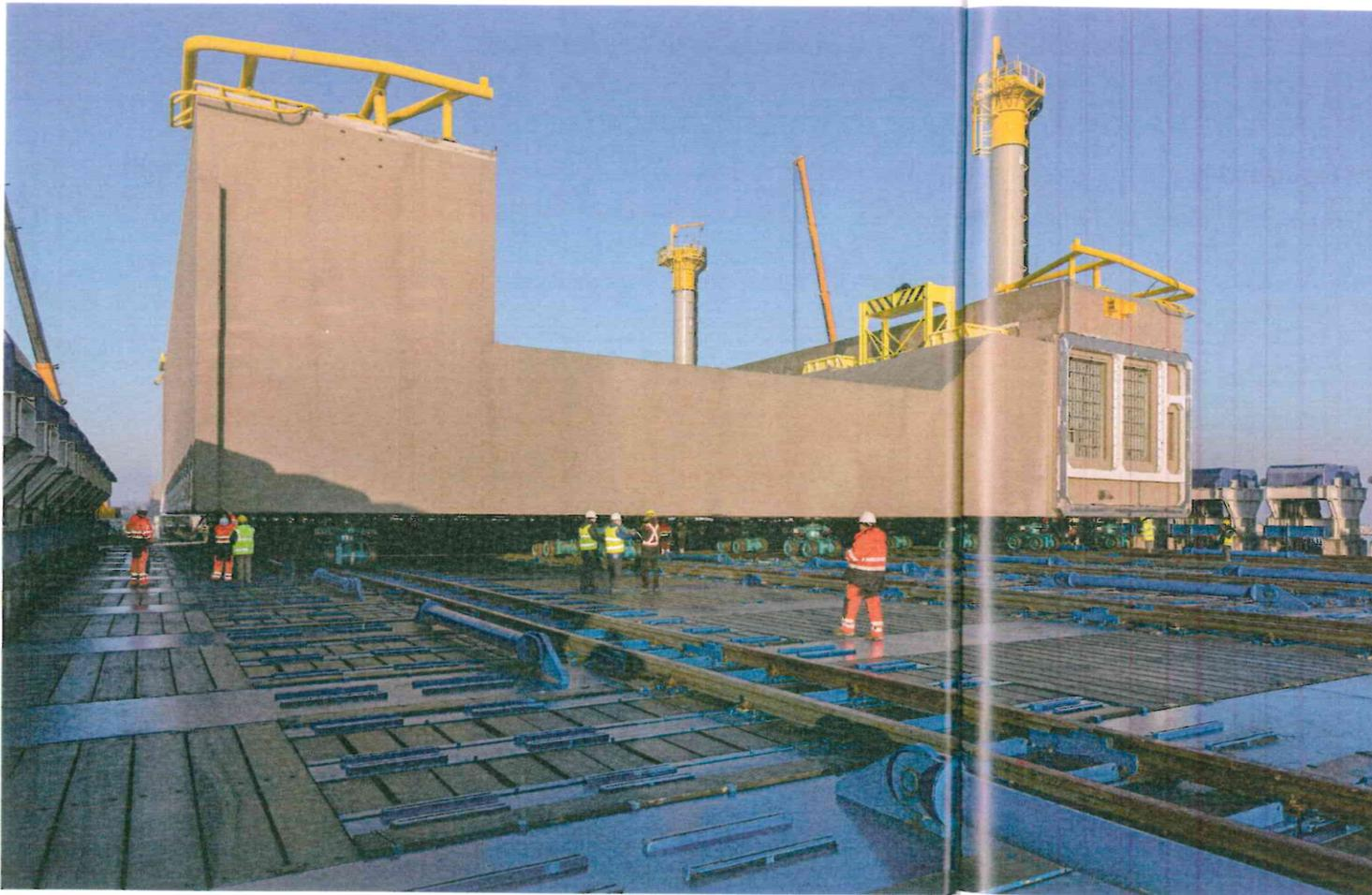
La sequenza del varo del primo cassone di alloggiamento per la schiera di paratoie di Lido sud. Il cassone è stato calato in acqua abbassando la piattaforma mobile del Syncrolift grazie all'azione di 26 potenti argani
