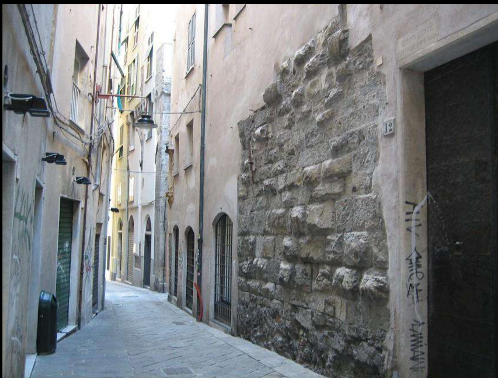
Tratto di muratura che si suppone pertinente alle mura caroline, IX secolo Attuale via Tommaso Reggio
